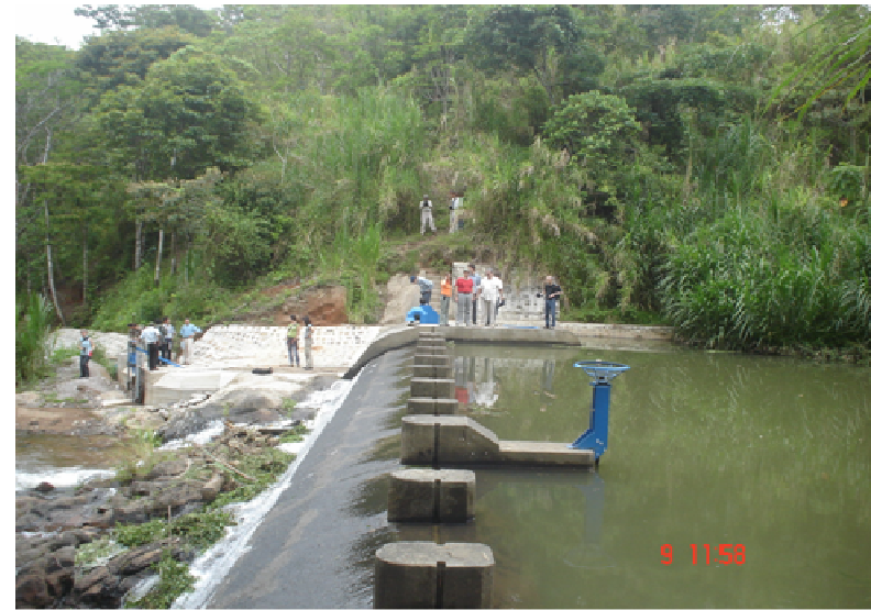
Represa y Obra de toma
