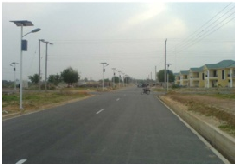
// Sistema de iluminação, Nigéria
