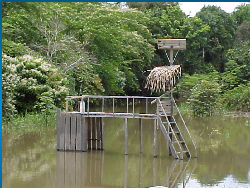
Painel fotovoltaico para bombeamento de água
