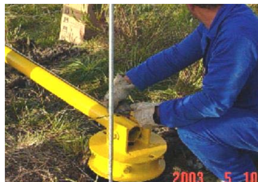
(b) Detalhe da fixação da torre
