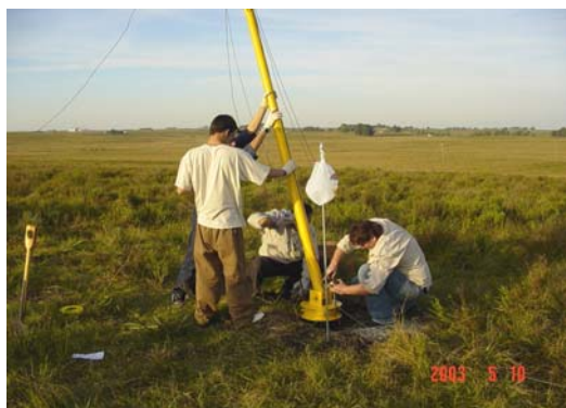
(a) montagem da torre
