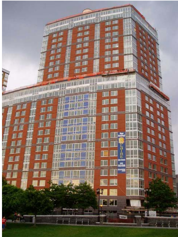
Fig. 1: Solair – Solaire, New York BIPV façade
