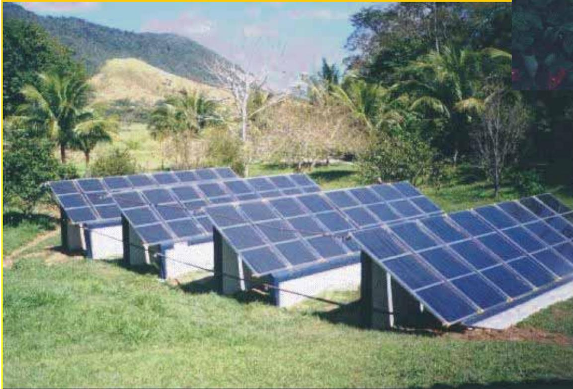
**Coletores planos sem vidro fabricados em metal ou polímeros plásticos de alta densidade.**
